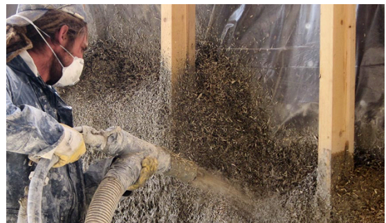
FIGURE 31 - BÉTON DE CHANVRE PROJETÉ (PIOEUVRE.FR)
