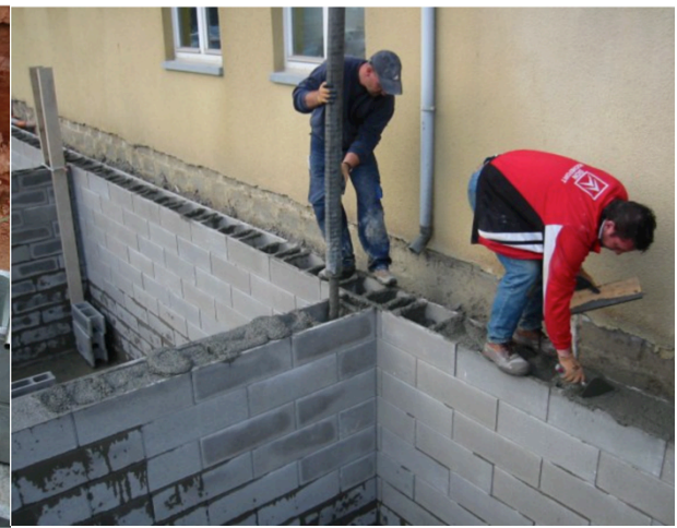
FIGURE 12 - COULAGE DU BÉTON DANS LES BLOCS (BETONDELALOMME.BE)
