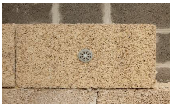
FIGURE 33 - ROSACE D'ATTACHE DES BLOCS DE BÉTON DE CHANVRE (ISOHEMP.BE)
