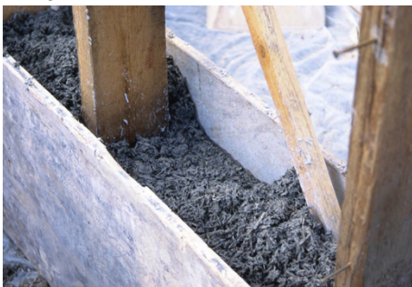
FIGURE 30 - BÉTON DE CHANVRE BANCHÉ (TERREVIVANTE.ORG)
