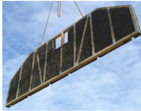
FIGURE 37 - PAROI PRÉFABRIQUÉE EN BÉTON DE BOIS (PREFER.BE)
