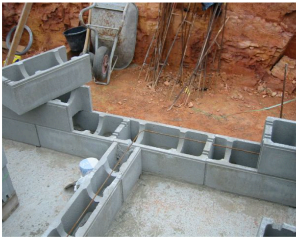
FIGURE 11 - MISE EN OEUVRE DU BLOC STEPOC (BETONDELALOMME.BE)
