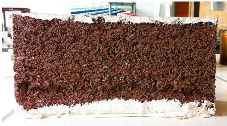
FIGURE 75 - FISSURE DE RUPTURE DANS UN BLOC
